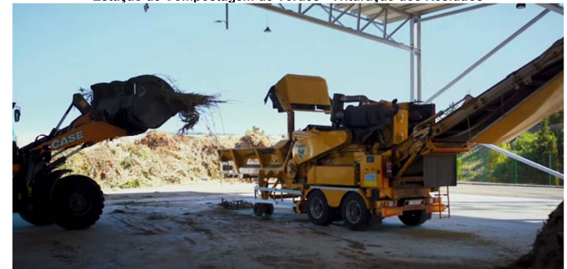
Estação de Compostagem de Verdes - Trituração dos Resíduos
