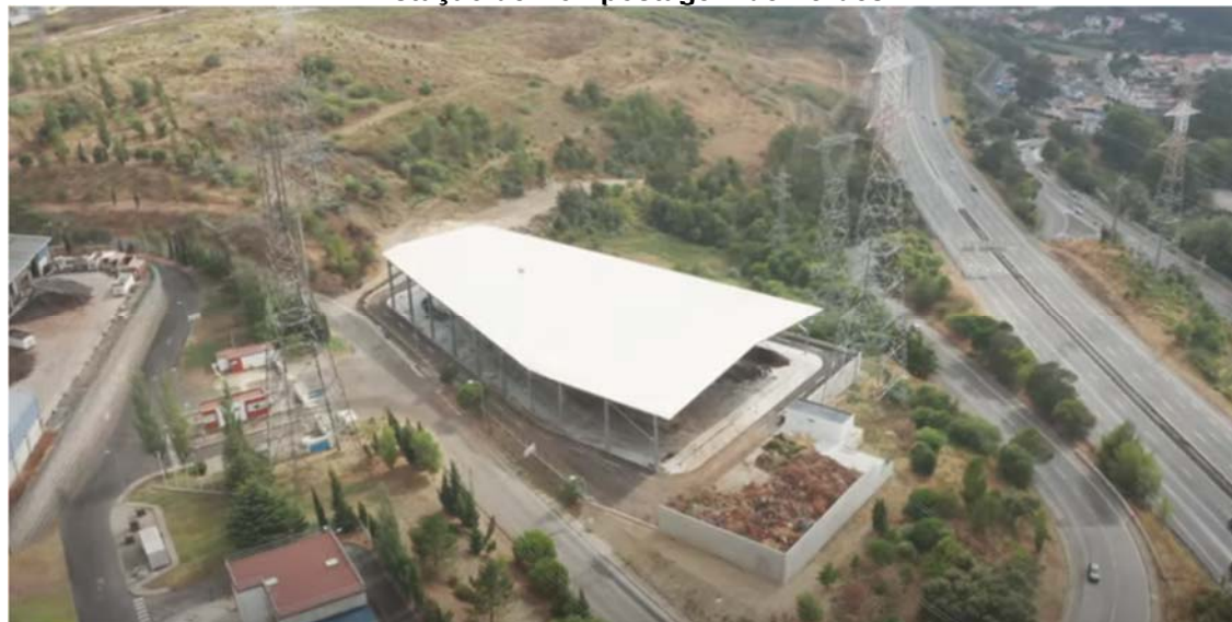
Estação de Compostagem de Verdes
